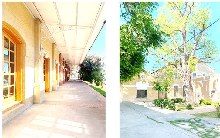
FIGURA III.38. Antigua Aduana de Nuevo Laredo. Levantamiento propio. 2024.
