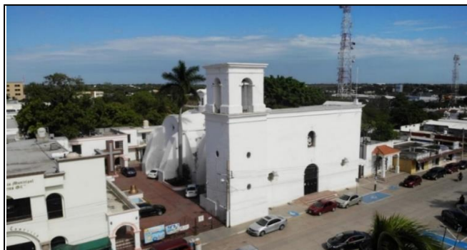
Ubicación de la Parroquia Santiago Apóstol en el centro de la ciudad. Fuente: C.S.M.A.T
