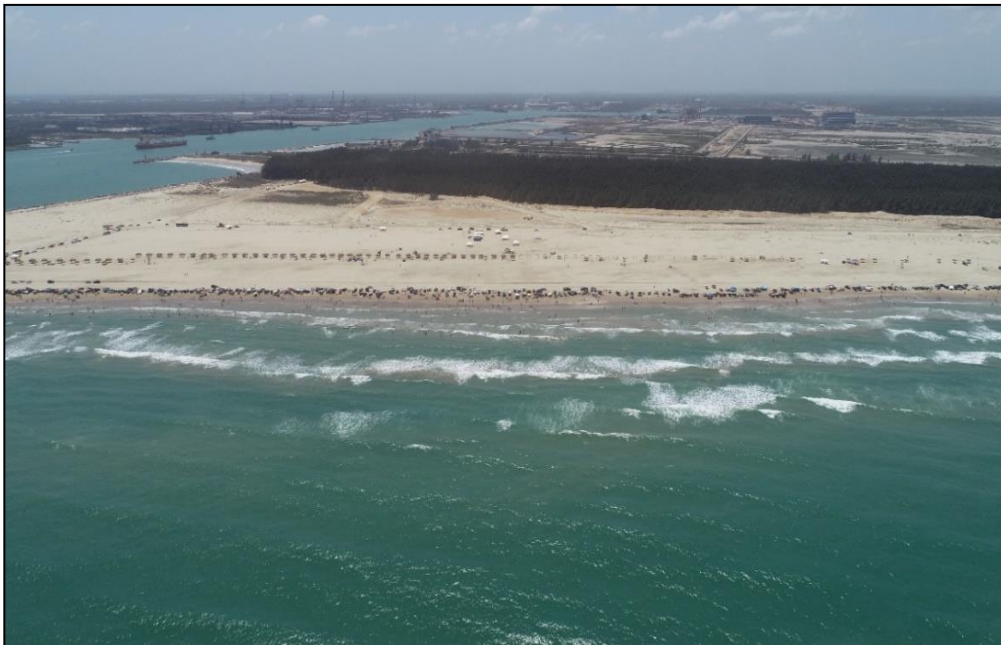
Vista aérea del margen de la playa ubicado en el municipio de Altamira. Fuente: C.S.M.A.T.
