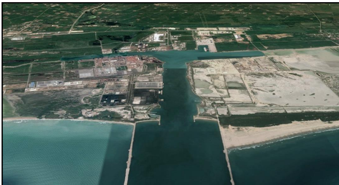
Vista general aérea del Puerto Industrial. Fuente: C.S.M.A.T
